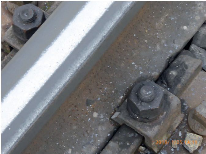
Abb. 5: Verschleißbild der Schiene in der Geraden (links), Übergangsbogen Bogeneinfahrt (rechts).
