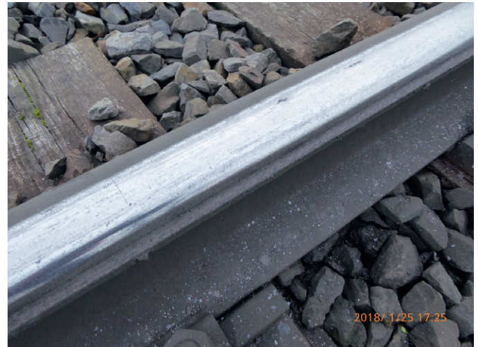
Abb. 5: Verschleißbild der Schiene in der Geraden (links), Übergangsbogen Bogeneinfahrt (rechts).
